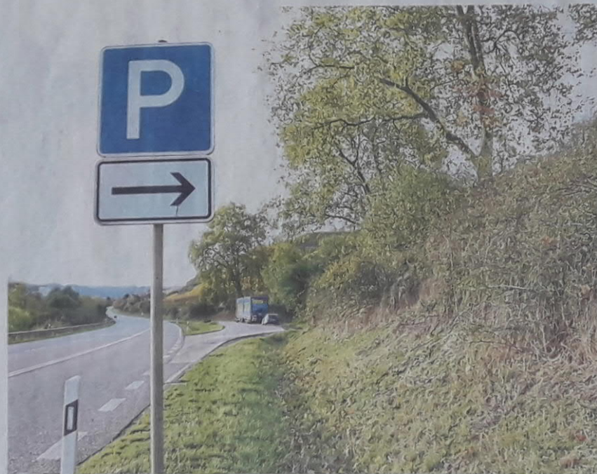
Seine Tage sind gezählt: Der Rastplatz Halenberg zwischen Bad Sobernheim und Monzingen. Weil die Bundesstraße 41 dort einen Überholstreifen in Richtung Monzingen bekommen soll – in der Gegenrichtung gibt es bereits zwei Fahrspuren –, muss der Parkplatz laut Landesbetrieb Mobilität weichen.
